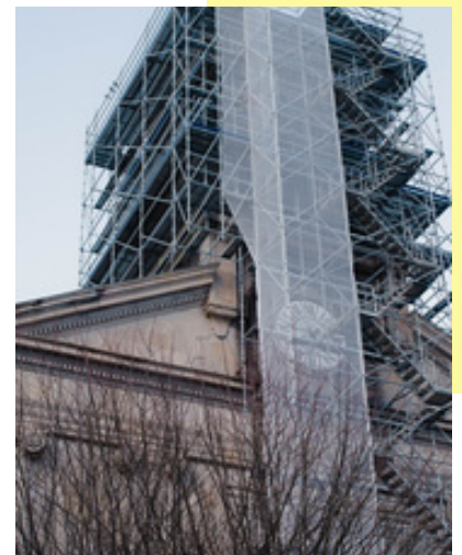
Le temple en plein travaux
